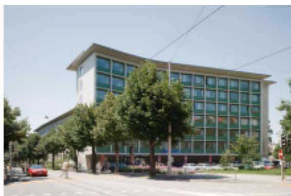
La façade de la Direction générale des douanes à Berne (Architectes Reinhard et Stücheli, 1951-53) est typique des années 50. Photo: Dominique Wehrli
