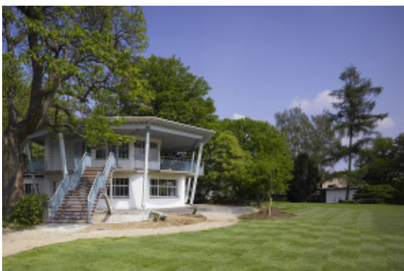
La piscine à ciel ouvert du Letzigraben à Zurich (Architecte: Max Frisch, 1942-49) a été récemment rénovée avec soin. Photo: Hannes Henz
